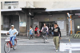
西区と此花区を繋ぐ、安治川川底トンネル
