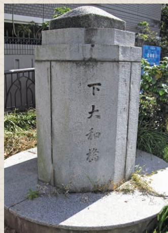
道頓堀川の下大和橋北詰にある、旧親柱
