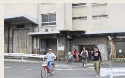
軍用トラックを通す予定であった、安治川川底トンネル
