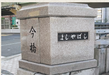
葎屋橋と今橋 V字の道筋で、江戸時代から親柱を共用していた。
